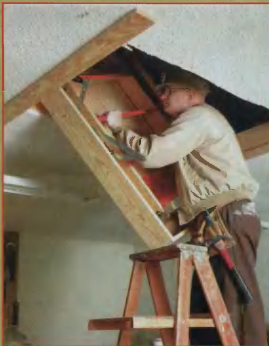
IV. Временная опора. Лежни, привернутые шурупками к потолку на время монтажа, держат лестницу, пока мастер регулирует положение люка и приворачивает его шурупками к проему.
