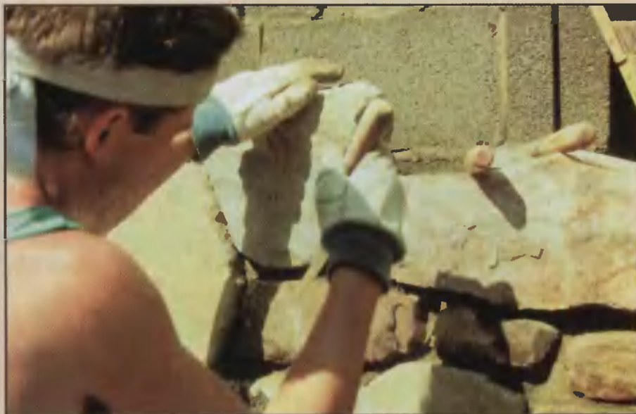
V. Вначале выкладываем углы, переходя затем к середине каждой стены. С лицевой поверхности стены рвствор тщательно счищаем.
