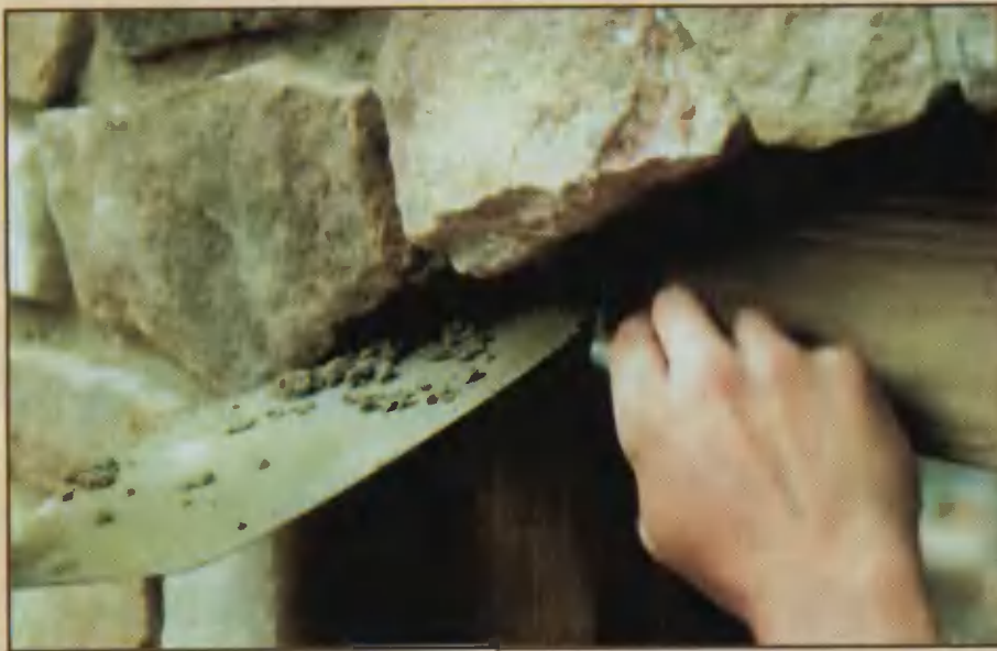
VII. Когда раствор схватился, в кружало убрано из-под арки, можно приниматься за расшивку швов.
