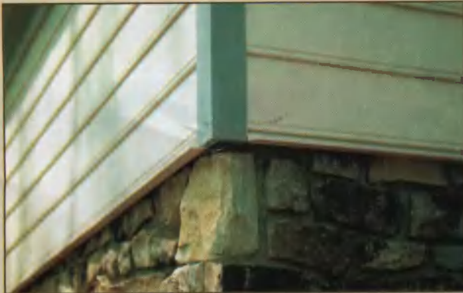
VIII. Отделка верхней части дома. Постройку венчает второй этаж с обычным брусковым каркасом. Этаж обшит древесно-волокнистыми плитами с раскладками.
