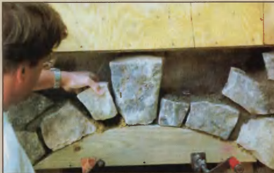
VI. "Прецизионный" стык. При возведении врки камни сначала укладываем поверх кружалв сухую. Кружало — временнвя опорв. Звтем квмни свжвем нв растворе, рвботая от пятого квмня (нвчинающего искривленную плоскость) на краю врки. Песок нв кружале не двет рвствору попвсть нв нижнюю поверхность квмней арки.
